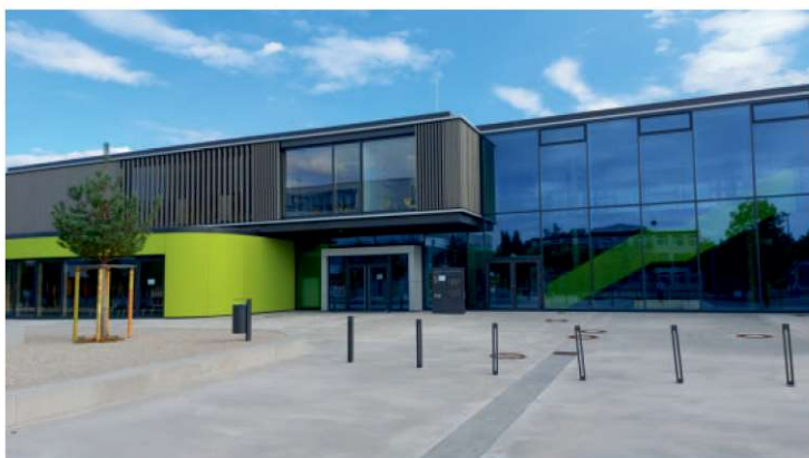
Neue Grundschule an der Krenmoosstraße
