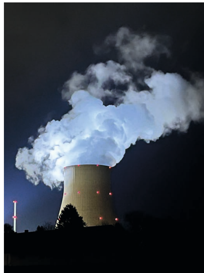
Ein letzter Blick auf das Kernkraftwerk in Unterahrain
