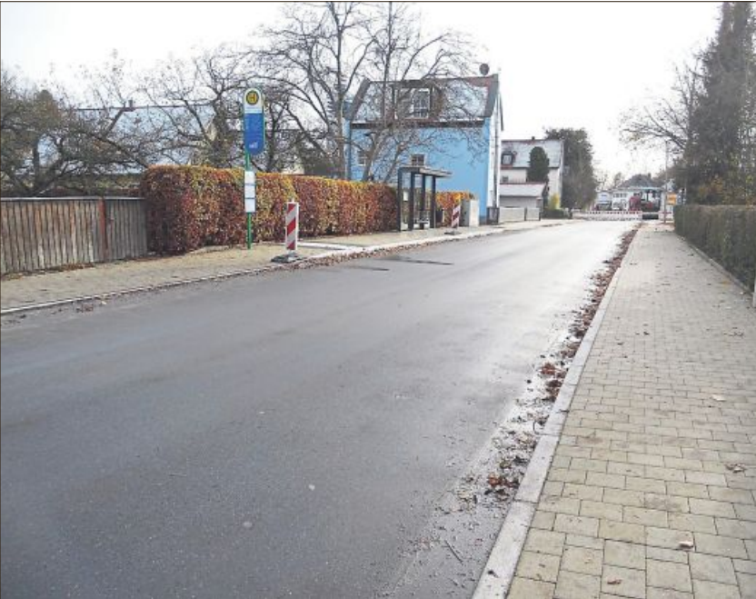
In acht Bauphasen wurde die Ortsdurchfahrt umgebaut.
