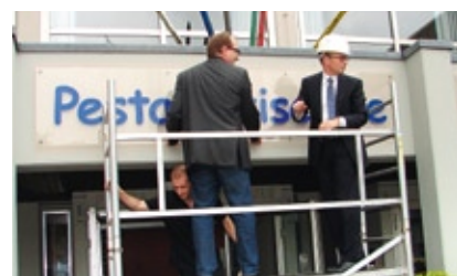
Uns wichtig: Die Sanierung der Pestalozzischule
