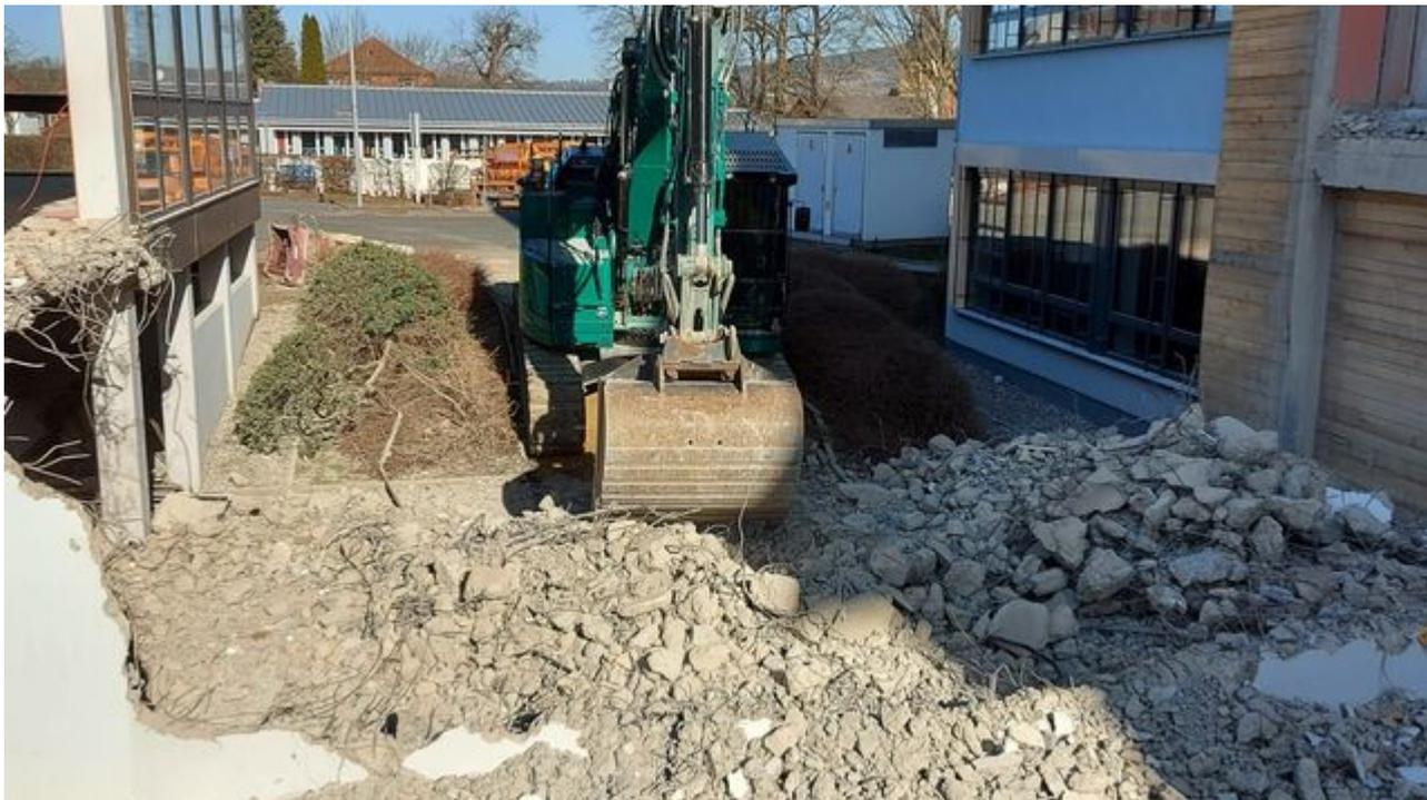
Im Bereich des bisherigen Verbindungsganges erfolgt die Verlegung der neuen Versorgungsleitungen. Der Neubau sieht wieder einen Verbindungsgang vor, allerdings wird die Verbindung zwischen den Gebäuden dann barrierefrei (ohne die bisherigen Stufen) sein.
