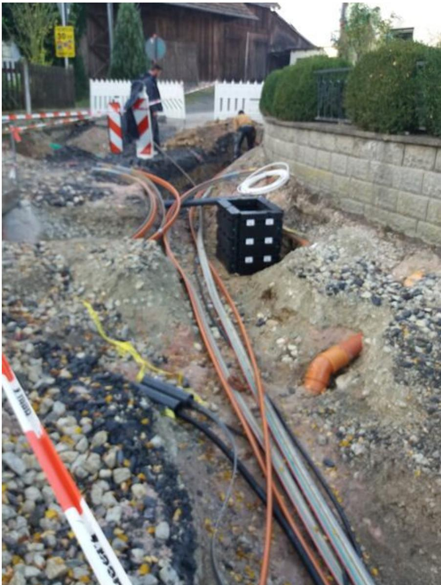
Die farbigen Leerrohre werden nach einem komplexen System in jedes Haus geführt. Das Foto zeigt die Leerrohrverbünde, die in Burkersdorf erstmalig durch die Marktgemeinde eingebaut wurde.
