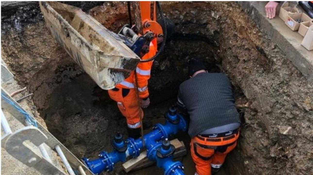
Eine Sonderschicht mussten die Bauhofmitarbeiter beim Wasserrohrbruch in der Bahnhofstraße zum Austausch eines Schieberkreuzes einlegen.
