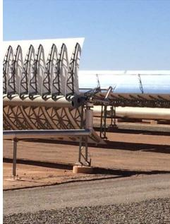
Das Großprojekt NOOR I in der südmarokkanischen Steinwüste. In kilometerlangen Parabolrinnen zirkuliert ein Thermoöl, das Dampf und schließlich Strom zu 12 Cent/kWh erzeugt. In weiteren Ausbaustufen folgen Solarfelder und Windräder. Das gesamte Areal umfaßt 3 000 Hektar. Es soll am Ende 1,3 Mio Menschen mit Strom versorgen. Über Land gibt es jedoch keine Leitungen.
