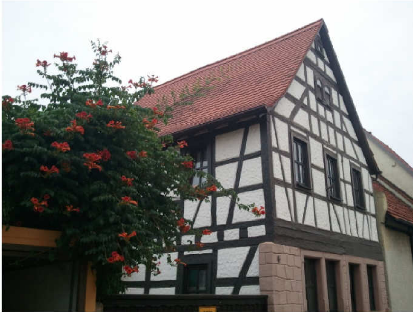
Blick in die Hauptstraße mit intakten ortsbildprägenden und meist giebelständigen Gebäuden unmittelbar entlang der Hauptstraße
