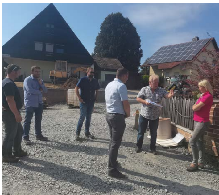
MdB Dr. Silke Launert, Ingenieur Michael Schneider IBT Bindlach, Bürgermeister Oliver Dietel, Sascha Haas IBT Bindlach, Jörg Würstl IBT Bindlach, Bauleiter Marcel Leistner Fa. WTU – Inspektion der der Kanalbaumaßnahmen im Wohngebiet.
