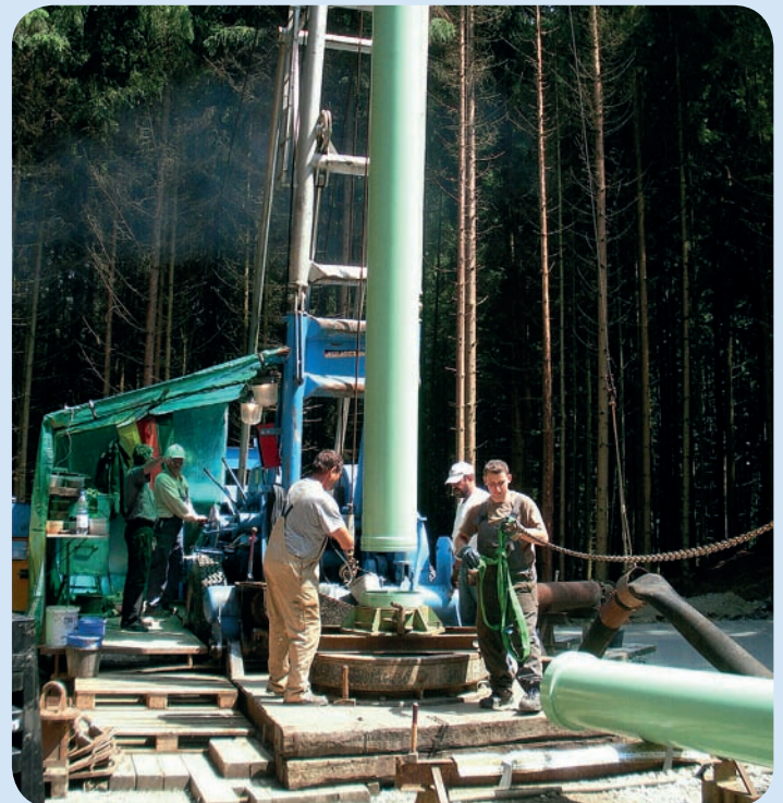
Brunnenbohrung am Stauffersberg
