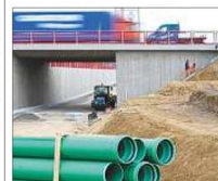
Die Baustelle am Südpark Neuburg mit Unterführung unter der Bundesstraße 16. Foto: Janda
