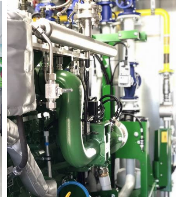
H2-Blockheizkraftwerk
