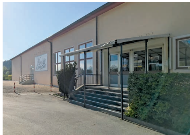
Der aktuelle Eingangsbereich ist alles andere als einladend
