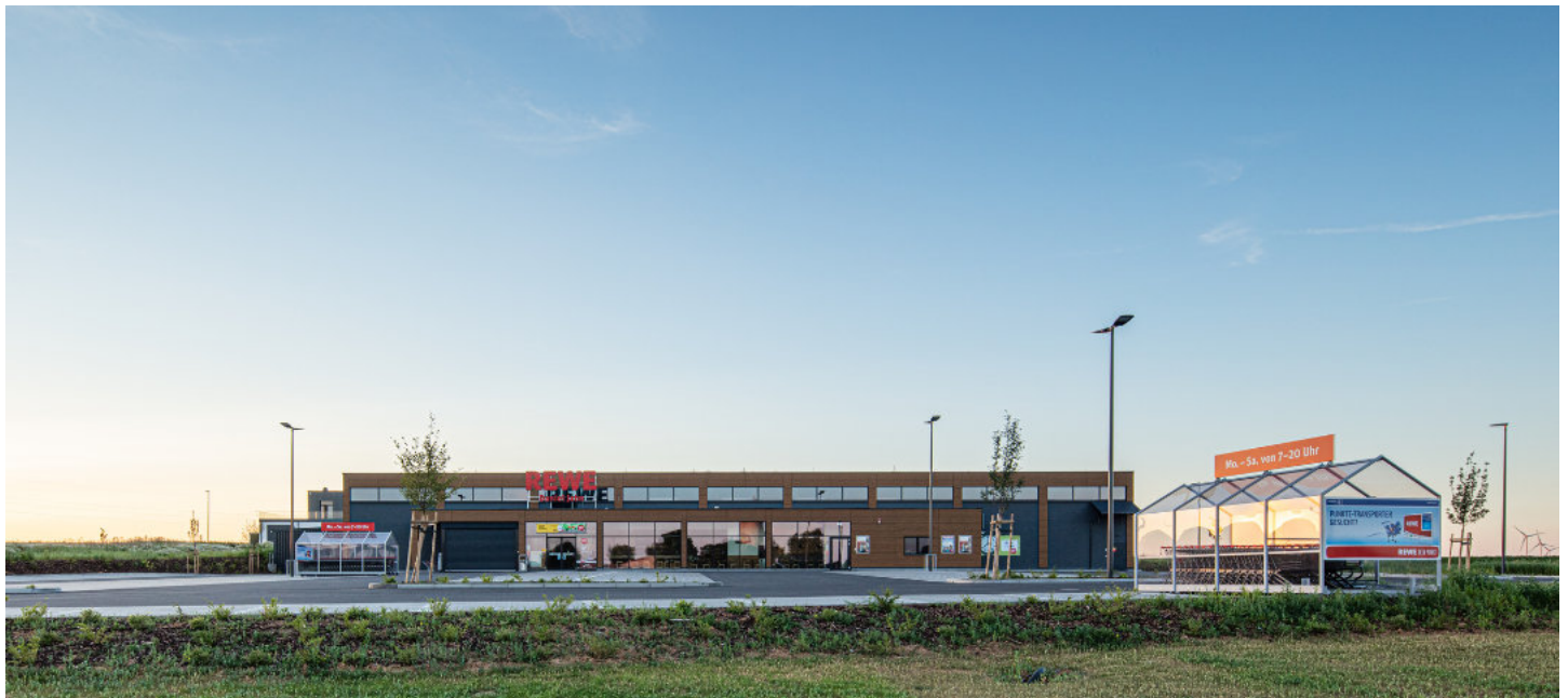
Die Bauweise der neuen REWE-Märkte ist naturintegriert, energetisch nahezu autark und mit viel Holzbestandteilen.
