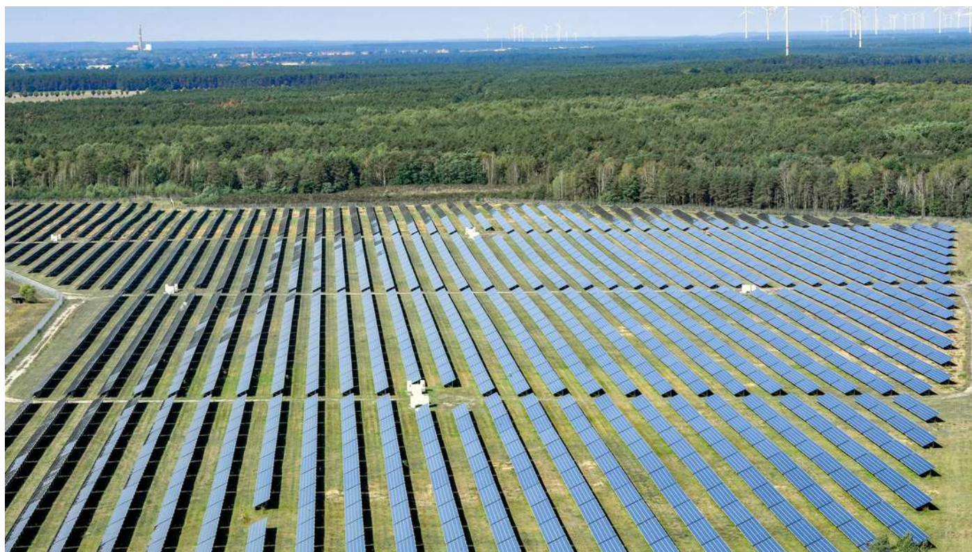
Eine Photovoltaik-Freiflächenanlage in Brandenburg. Rechts hinten gesellen sich Windräder dazu. © Pleul/DPA
