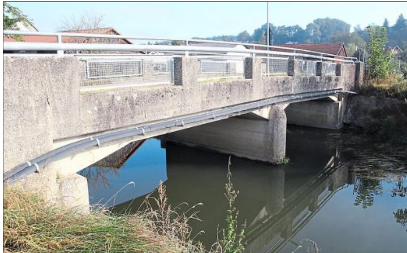
Die Tage der alten Hartlbrücke sind gezählt, die neue Brücke wird wegen der Durchflussvergrößerung keinen Mittelpfeiler mehr haben. Foto: Bernd Spanier
