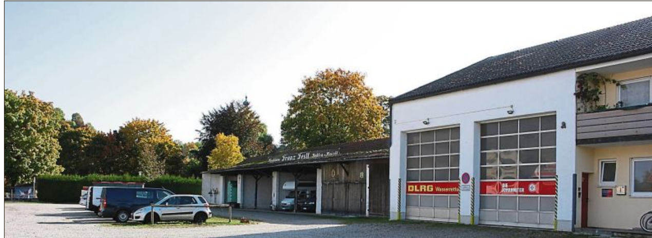
Auf diesem derzeit bebauten Areal soll ein Komplex mit unter anderem Arztpraxen und einer Apotheke entstehen.
