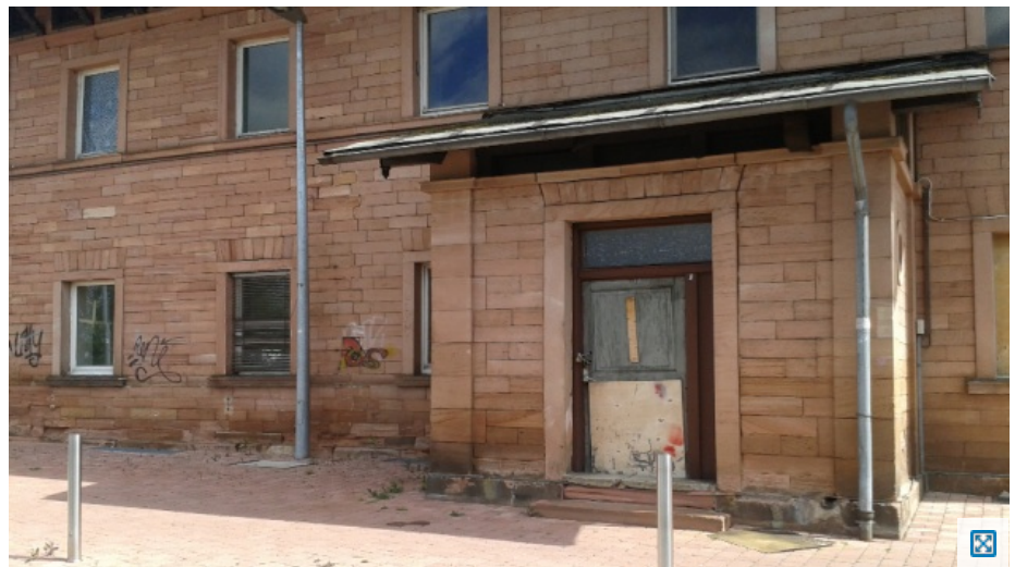
Der Bahnhof Kleinstheim im derzeitigen Zustand - 07.10.2016
