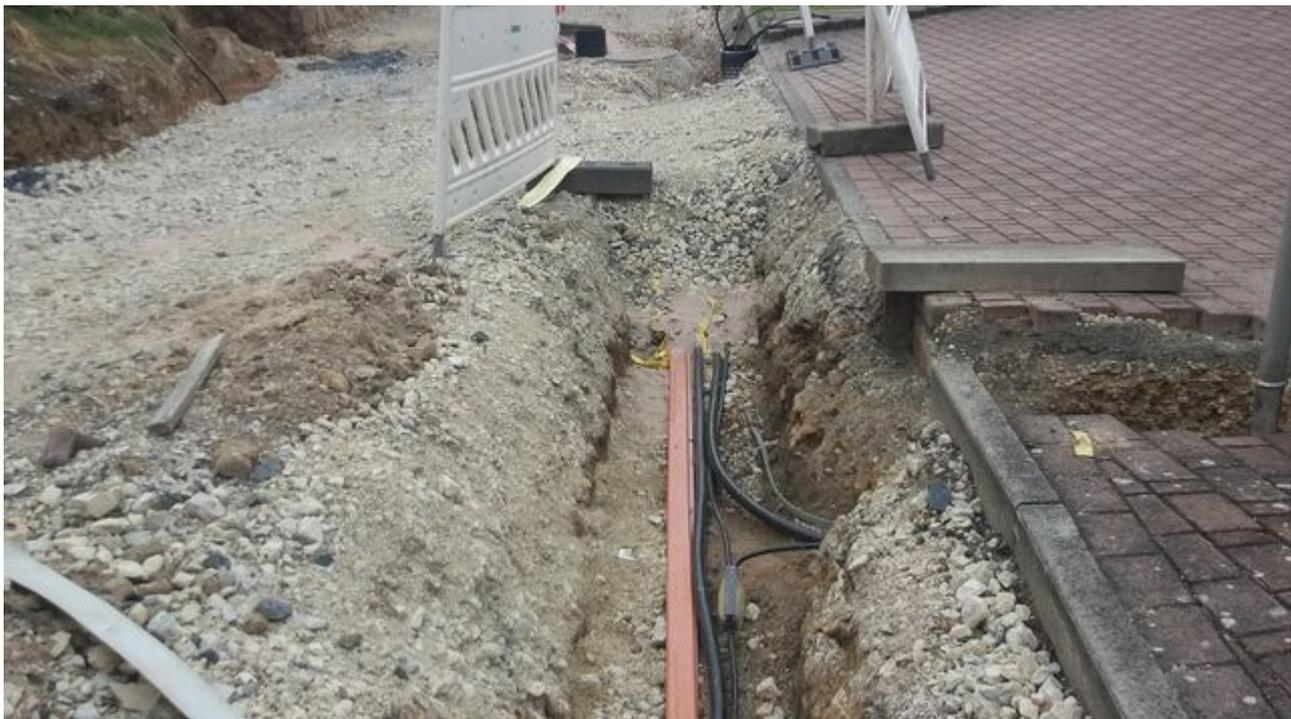
Die Dorferneuerung in Burkersdorf ist in der Straße „Am Bach“ aktiv. Die im Rohrgraben erkennbaren farbigen Kabelverbünde sind die Leerrohre für Glasfaser, die seit 2018 bei umfassenden Baumaßnahmen vom Markt Küps eingebaut werden.
