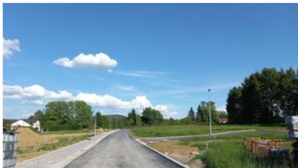
In Kürze werden die Erschließungsarbeiten für das kleine Wohngebiet „Lohäcker“ in Burkersdorf abgeschlossen sein. Ein Teil der neuen Ortsstraße ist bereits asphaltiert, die Deckschicht folgt in den nächsten Wochen. Ende Juni wird das Baugebiet offiziell übergeben. Damit können die 16 Bauwerber, die teilweise schon die Grundstücke erwerben konnten, mit dem Umsetzen ihrer Pläne beginnen. Einige Bauanträge wurden bereits
