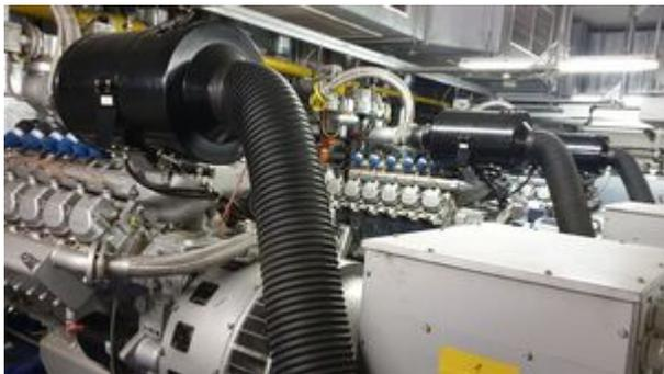
Nach der Maschinenhalle ging es in einem kleinen Fußmarsch an das Miltenberger Hallenbad. Im Untergeschoss des Schwimmbades verbirgt sich ein Blockheizkraftwerk mit drei Gasmotoren. Diese liefern sowohl Strom als auch Wärme für die Beheizung des Schwimmbades und den Betrieb des angeschlossenen Nahwärmenetzes.
