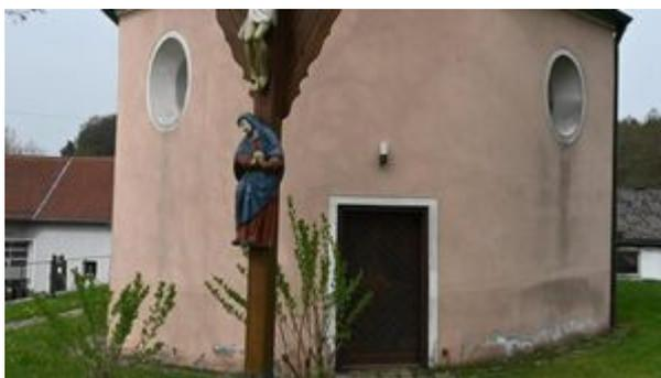
Links und rechts der Sakristeitür fällt der Putz bedingt durch die Nässe auf der ganzen Länge ab.
