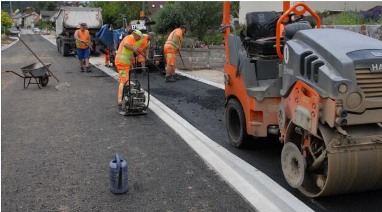
Auch die Gehwege und Mehrzweckstreifen wurden mit der Tragschicht asphaltiert.
